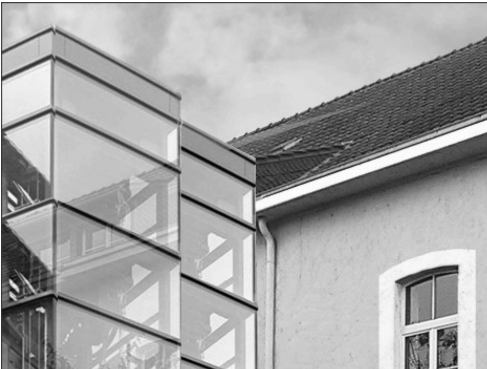
Bezbariérové úpravy - výtah
